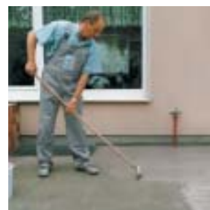
3. Stendere la prima mano di PCI-Seccoral (diluito al 10% con acqua) in modo continuo sul sottofondo bagnato.
