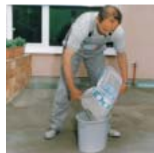
2. ... miscelarlo senza grumi con PCI-Seccoral componente in polvere.
