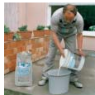
1. Versare di PCI-Seccoral 2K componente liquido in un contenitore pulito e ...
