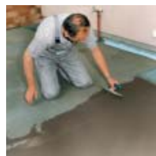
4. Stendere il secondo ed ev. il terzo strato con una spatola per lisciatura fino a uno spessore complessivo di max. 5 mm non appena lo strato precedente non appiccica più, ma è ancora leggermente umido.
